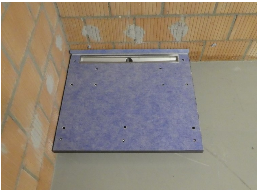
Abbildung 3: Gesamtansicht von Prüfaufbau 1 (Aufbau Nr. 3.1 vom 26.02.2020)
