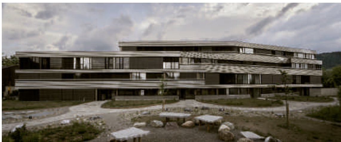
Anmutung eines Schiffes: Vorne Wasser, hinten Naturgarten (u. l.), rohe Materialien im Innenraum FOTOS: MICHAEL EGLÖFF
