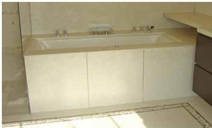
Die „Whirlbox“ ist ein geschlossener Wannenunterbau mit vollflächiger Schall-, Vibrations- und Wärmedämmung sowie integrierten Serviceöffnungen für den Zugang zur Technik. Schallschutzwerte < 25 dB(A) sollen sich damit realisieren lassen. Der Wannenunterbau wird grundsätzlich nach Maß gefertigt.
