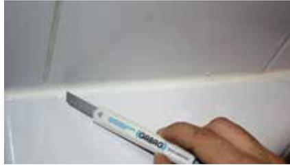
Dank einer metallischen Einlage in der „Flexzarge Schnitenschutz“ können Dichtschäden im Zuge einer Silikonfugenerneuerung vermieden werden.
