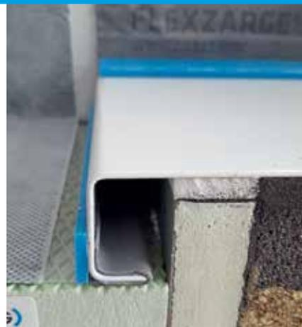
Als Abdichtungslösungen für z. B. bodenebene Duschen bietet sich die „Gabag Flexzarge Schnitenschutz 3D“ an.
