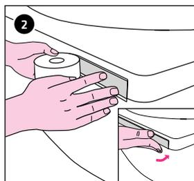
2 Posare in un solo pezzo il nastro in butile a filo del bordo superiore del bordo vasca. Sugli angoli della vasca posarlo attorno alla curvatura. Installare il nastro in butile solo dove successivamente si applica il nastro GABAG FLEXZARGE®. Posare il nastro in butile sotto il bordo vasca e premere accuratamente. Togliere la pellicola protettiva.
