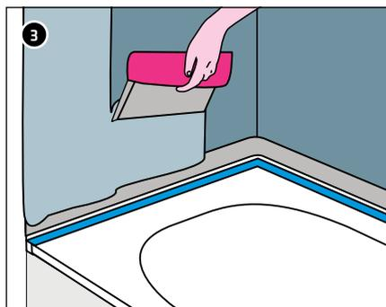
3 Applicare una seconda mano di tenuta ermetica sul nastro di tenuta incollato.
