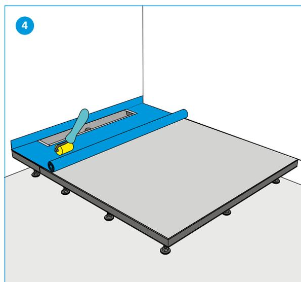
Nachdem die höhenjustierbaren Schallschutzfüsse mit Loctite fixiert und die Dichtschrauben eingedreht wurden, GABAG Duschboden mit GABAG Montagekleber vollflächig überziehen und mit einem Spachtel abziehen. Mitgelieferte Dichtband falten- und wellenfrei aufkleben.
