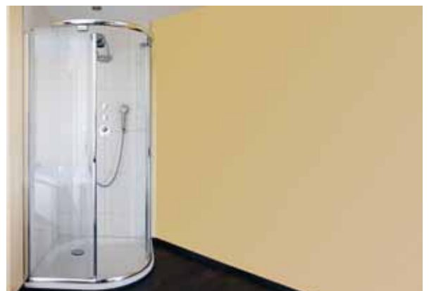
MEHRFAMILIENHAUS MEIERSKAPPELSTRASSE, UDLIGENSWIL
